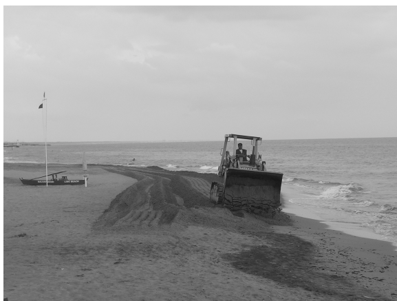
Fig. 3 – Gli operatori balneari alterano il profilo della spiaggia appiattendola, amplificando così gli effetti delle mareggiate e facilitando l'ingresso marina
